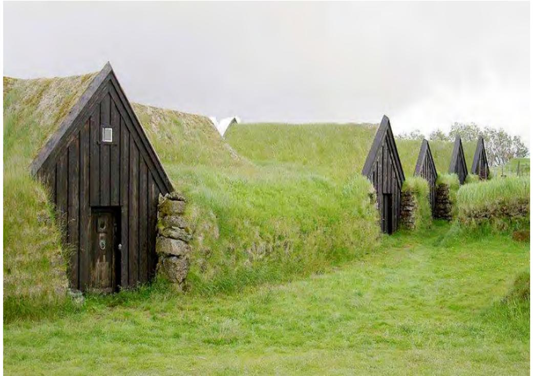
La solución de cubierta invertida vegetal contribuye a aumentar la inercia térmica de la cubierta, consiguiendo un mejor comportamiento bioclimático del edificio. Además, se recupera una buena parte de la vegetación que se ha perdido al construir el edificio.
