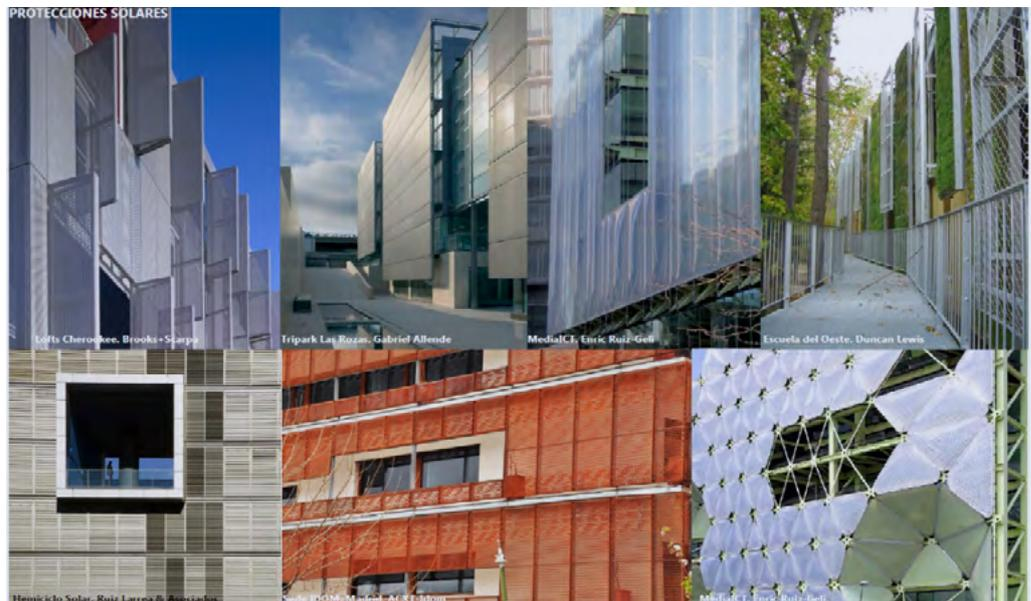
Hay muchos tipos de protecciones solares, pero quizá las más adecuadas son las protecciones móviles, ya que son más adaptables al clima y al cambio de radiación durante el año. Hay días en primavera y otoño en los que interesará calentar el edificio a través de la radiación solar y otros donde un exceso de radiación podría producir sobrecalentamiento de los espacios interiores.
