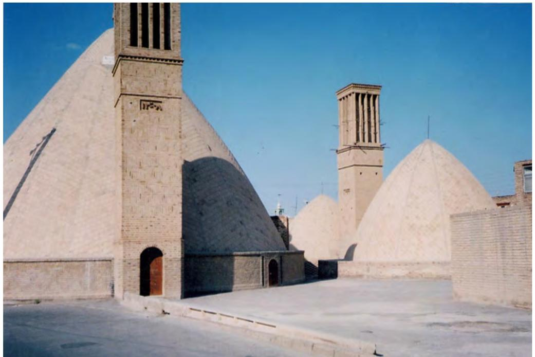
Su funcionamiento es muy sencillo, se trata de una torre alta adosada a la vivienda que tiene aberturas en la dirección de viento dominante en la zona y que produce una succión natural del aire interior de la vivienda.
